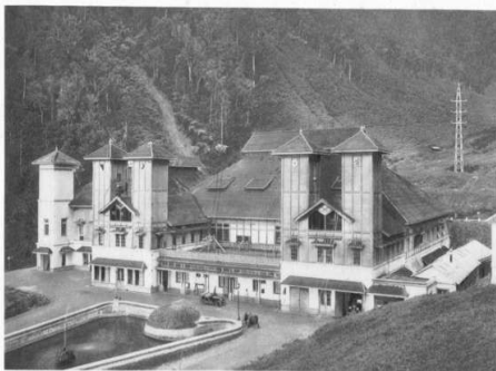
4. Gebouw van het station Malabar.
