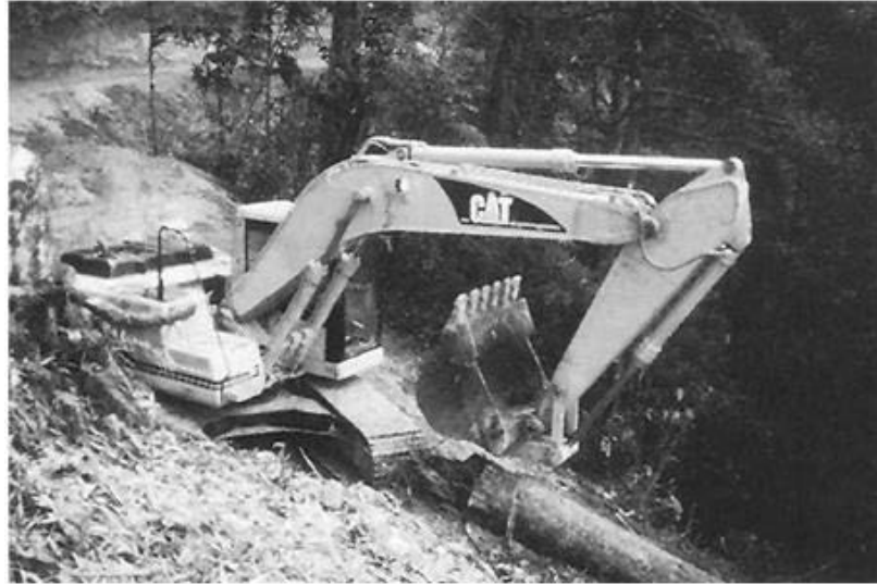
Gambar 28. Pembuatan Jalan Dengan Excavator
