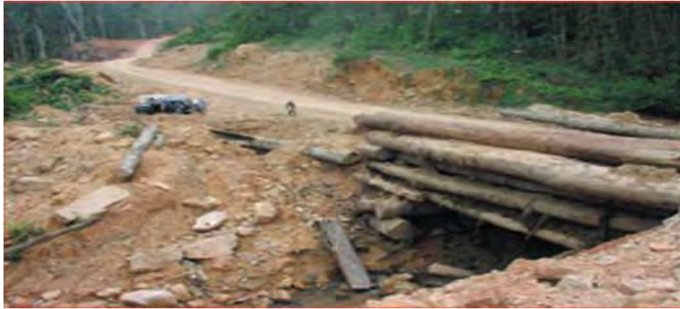
Gambar 41. Sifat Kuat Dan Tahan Lama Sering Tidak Ditemukan Pada Jenis Kayu Tropis, Akibatnya Penggunaan Balok Kayu Yang Ditumpuk Biasa Digunakan Pada Pembangunan Jembatan.
