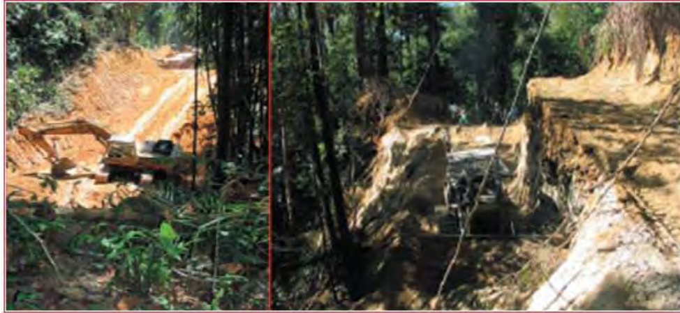
Gambar 33. Bahkan Pada Daerah Yang Landai Excavator Sebagai Mesin Pembuatan Jalan Utama, Bisa Mengungguli Bulldozer Dalam Menghasilkan Sub-grade Yang Lengkap Dengan Parit Di Pingir Jalan Dan Dampak Lingkungan Yang Minimal.
