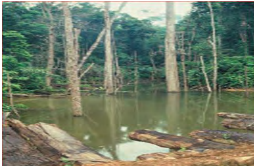
Gambar 35. Genangan Air Yang Terbentuk Oleh Gorong-Gorong Yang Salah Adalah Pemandangan Yang Lazim Di Beberapa HPH. Perhatikan 'Knappel' Yang Diperlukan Untuk Menstabilkan 'Road Fill' Yang Dipenuhi Oleh Genangan Air
