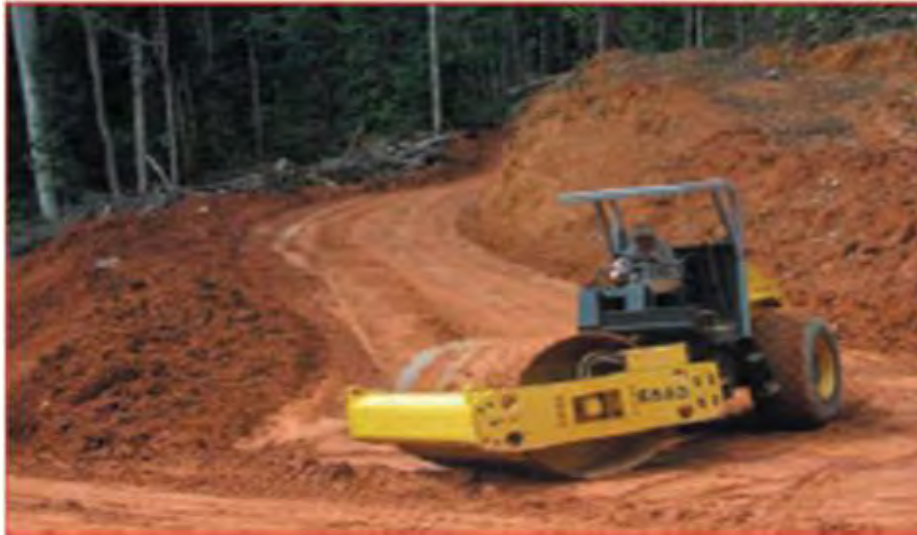
Gambar 36. Pematatan Jalan Dengan Menggunakan Bomag Conveyer
