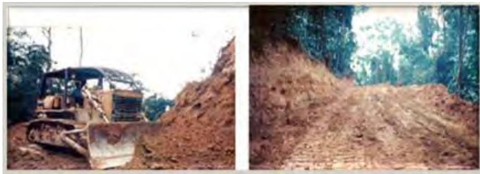
Gambar 34. Pembuatan Jalan Mengikis Tebing Dengan Menggunakan Bulldoser D55
