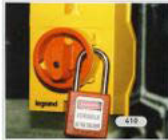
Gambar 1.10.: Kunci isolasi rangkaian
