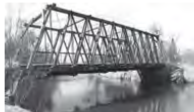
Gambar 9.27 Jembatan dengan tiang penyangga besi
