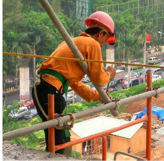
Gambar 1.5 Keselamatan kerja konstruksi
