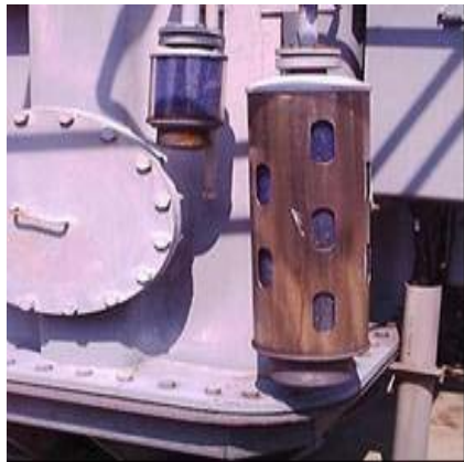
Gambar 3.13 Kontruksi alat pernapasan transformator
