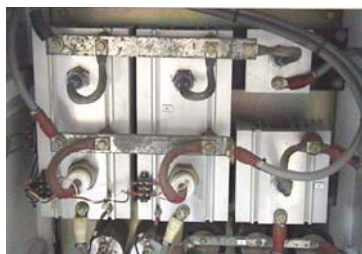
Gambar 1.28. Penyearah Thyristor 3 Fasa
