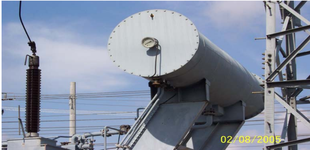
Gambar 3. 10. konservator minyak trafo
