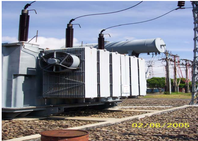
Gambar 3. 11 pendingin trafo type ONAF
