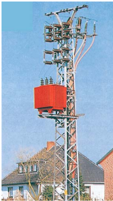
Gambar 4.44 : Pemasangan Trafo Outdoor
