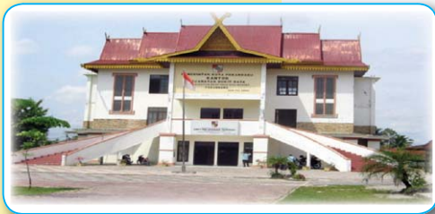
Gambar 5 Kantor Kecamatan Bukut Raya Pekanbaru. Sumber : http://i195.photo.bucket.com
