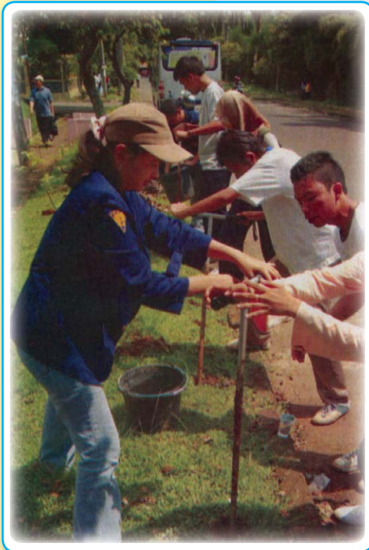
Gambar 18 LUBANG PENYERAP AIR. Kamir R. Brata memperkenalkan Biopori, yaitu lubang berdiameter 10-20 cm dengan kedalaman 1 meter, untuk menyerap air. Temuan ini lebih efektif daripada sumur resapan. Sumber : TEMPO, 24 – 30 Desember 2007
