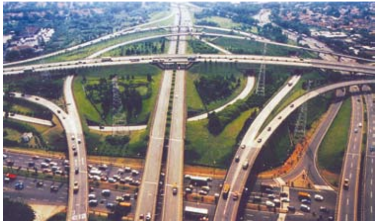
Gambar 7.19 Jalan layang di Jakarta.
